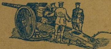
4. 105-миллиметровая английская дивизионная гаубица на платформе, на которой можно быстро поворачивать гаубицу (до 360 градусов). Стреляет снарядом в 15 килограммов на 13 километров. Вес орудия—около 2 тонн.
