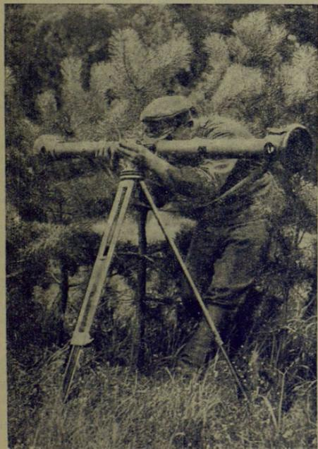
Боец определяет расстояние при помощи дальномера «инверт».
